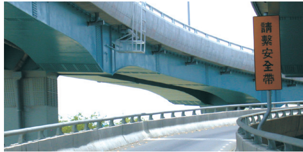
高速公路護欄
